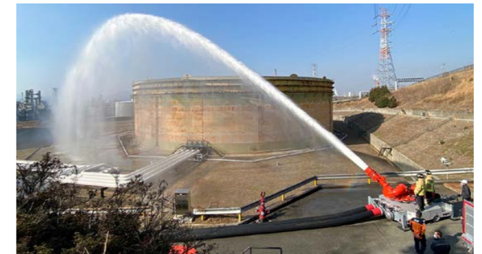
SK이노베이션 울산Complex 원유저장지역 대형 탱크(Tank)의 화재를 조기 진압하기 위해 '대용량 방사포' 국내 최초로 도입
